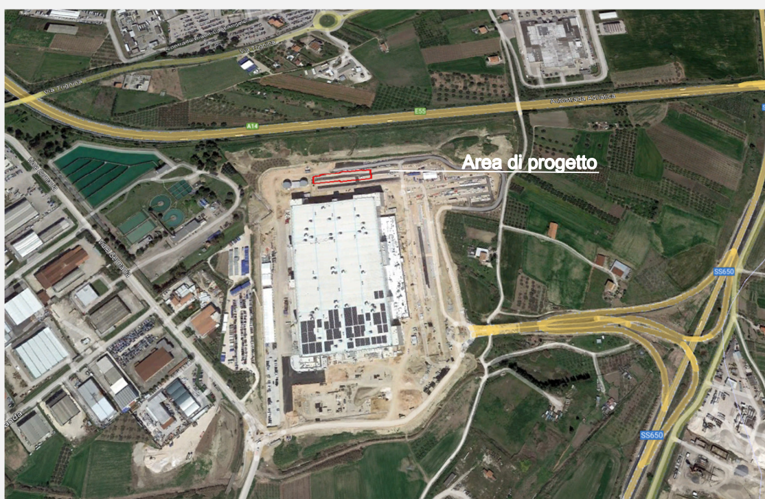
Figura 3: in rosso localizzazione area di progetto (posizionamento punto di decollo atterraggio droni)
